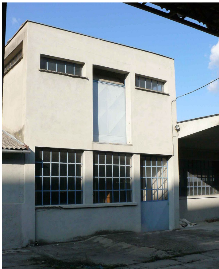
Foto 7 – Ex Pavital - Vista dall'interno
