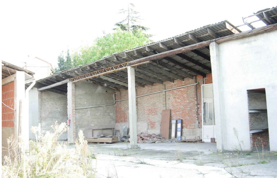
Foto 5 – Ex Pavital - Vista di tettoia interna
