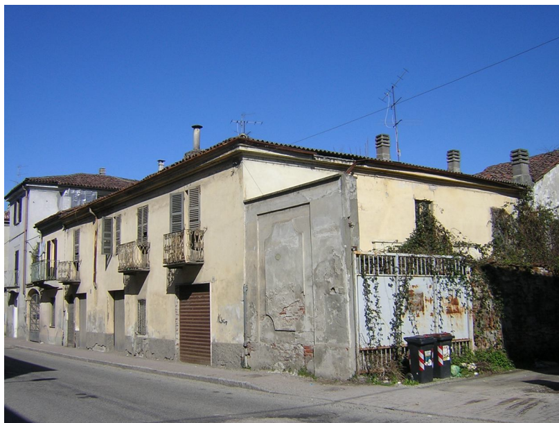
Foto 10 – Edificio di via XX Settembre - Vista di lato est
