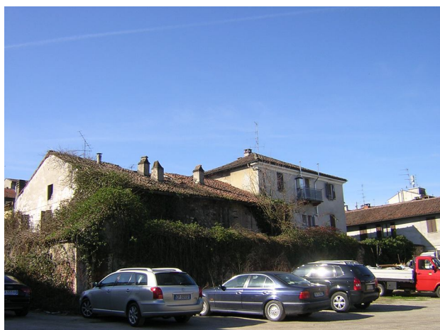
Figura 5 – Edificio visto dall'area per servizi
